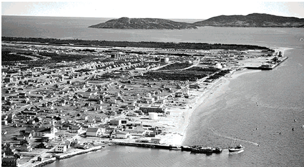
Sept-Îles en pleine construction
