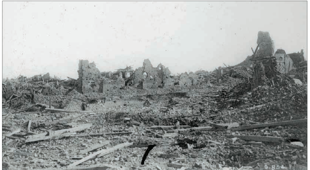
Église de Courcellette détruite après les bombardements
