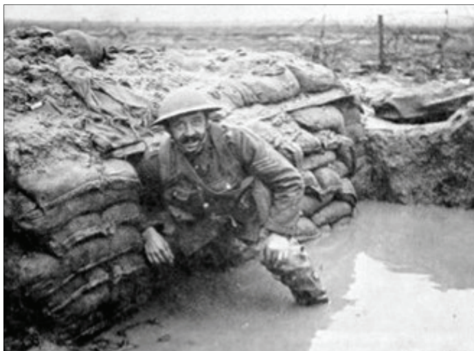
Tranchée pleine d'eau et de boue
