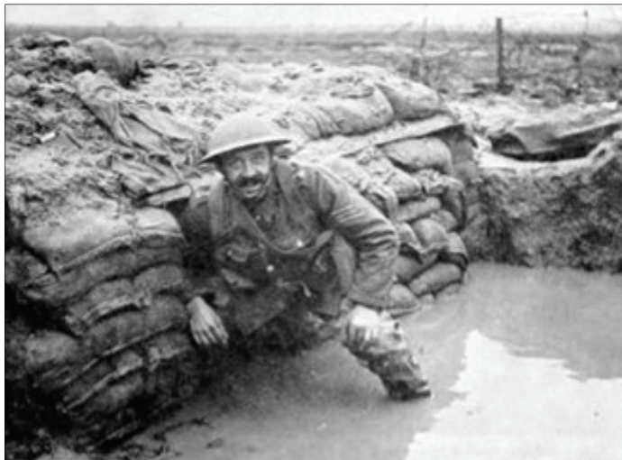
Tranchée pleine d'eau et de boue
