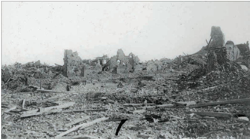
Église de Courcellette détruite après les bombardements
